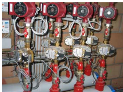
Παραδείγματα μικρών και μεγάλων εγκαταστάσεων θερμοδομετρητών Superstatic
