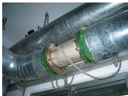
Παραδείγματα μικρών και μεγάλων εγκαταστάσεων θερμοδομετρητών Superstatic
